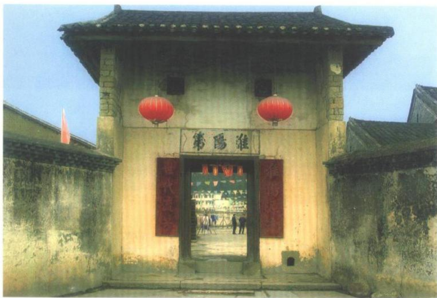
贺县莲塘白花圩江家围龙屋门楼。
