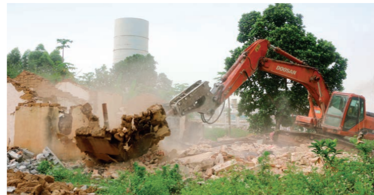
2019年4月11日，中航化、南珠新城征地拆迁现场 邓符 摄
