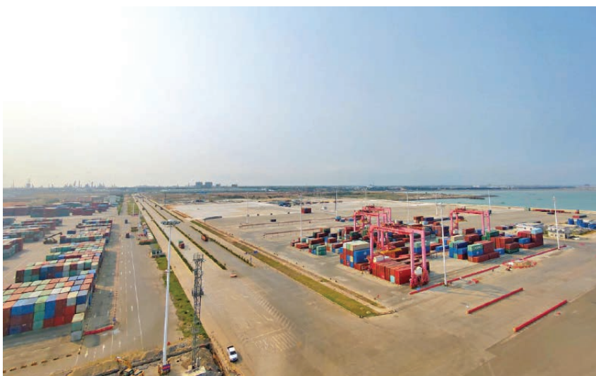
2019年,北海港铁山港作业区进港大道工程项目施工现场 北海港铁山港作业区 供
