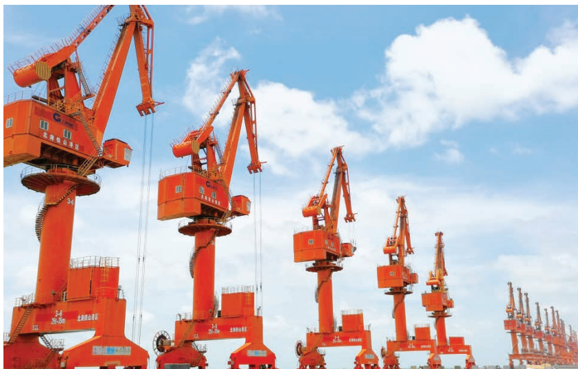
2019年7月2日,北海港铁山港作业区1号—4号泊位工程项目(二期)通过验收后投入使用 北海港铁山港作业区 供
