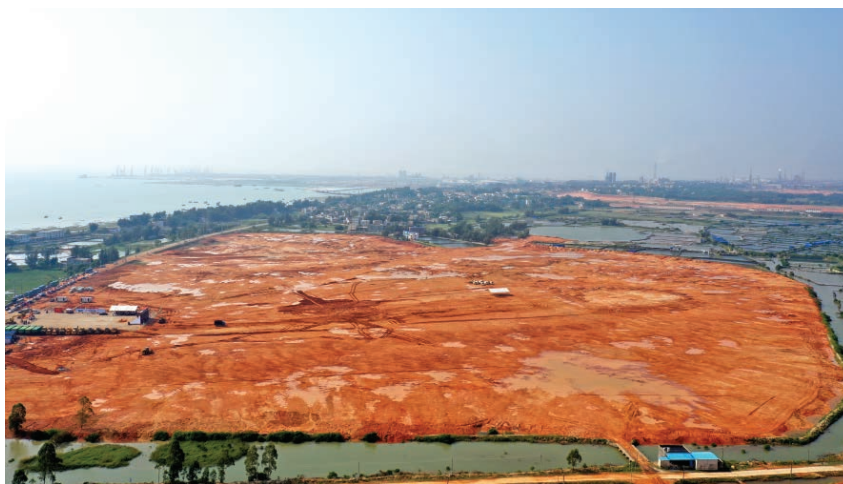
2019年,年产350万吨的太阳纸业林浆纸一体化项目建设现场
