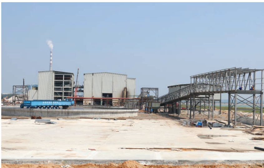
2019年,铁山港(临海)工业区内的信义玻璃项目建设现场
