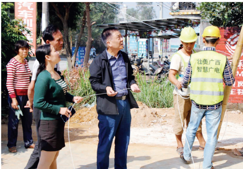
2019年,铁山港区推进“壮美广西·智慧广电”工程建设。图为11月22日工作人员在南康镇社内村安装线路 黄昌能 摄
