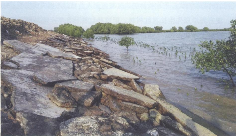
图 1-8 缺少红树林庇护而受损的海堤
