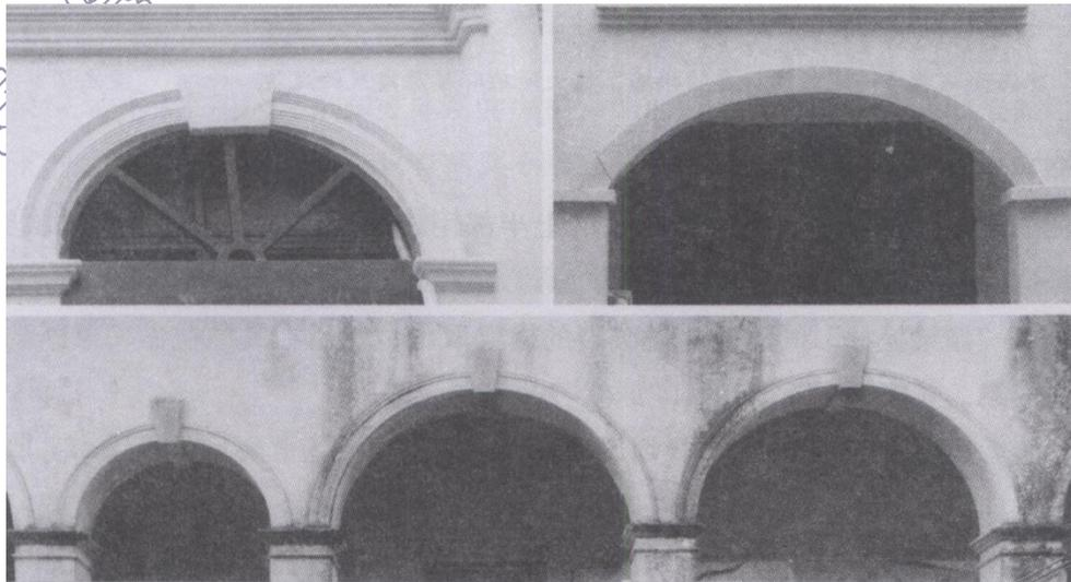
图二 图的上半部为珠海西路经整治过的两个拱券。左图拱券的拱心石过大；右图的拱券雕线因工艺问题没有做好。下半部为一百多年前建造的北海德国领事馆立面的局部，从拱券弧形，拱心石的形状大小，以及弧形雕饰线的流畅和线脚的制作，给人美的享受，体现一百年前建造该楼拱券的工艺水平。陈孝昭 摄
