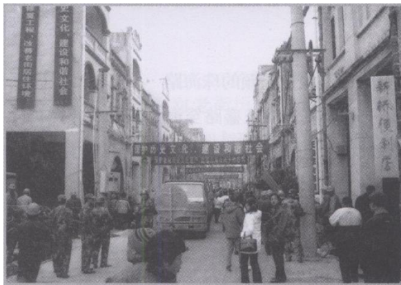
修复老街的工程车队开进珠海路。
