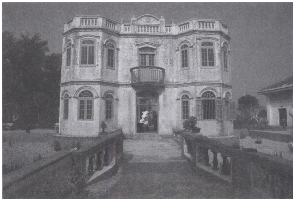
槐园的西式门楼和小桥。
