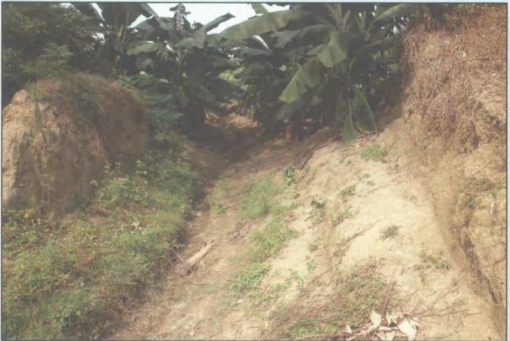
越州古城排水道遗址
