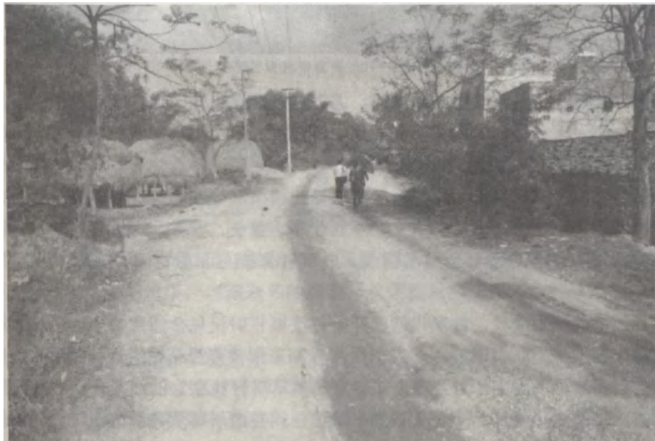
图 3-9 唐廉州城遗址城墙顶部
