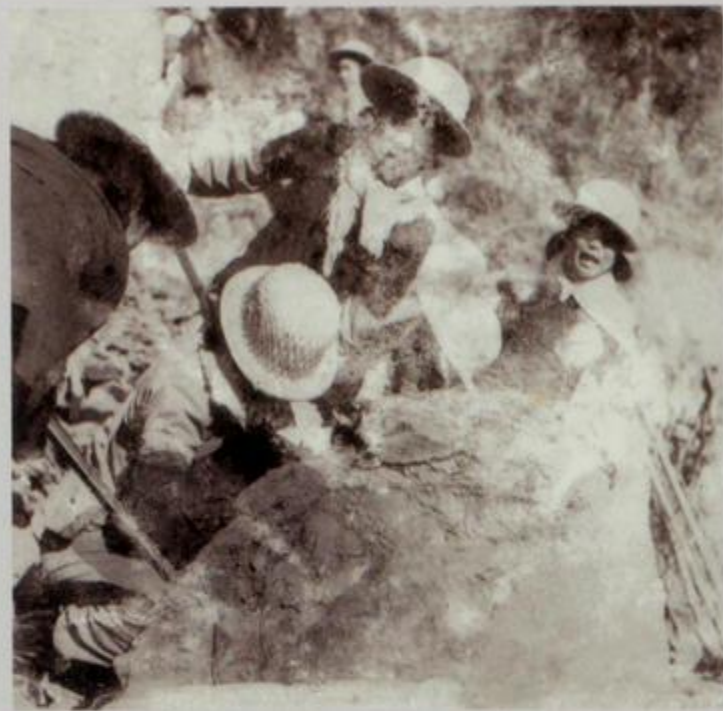
女民兵在枝柳铁路三江工地
