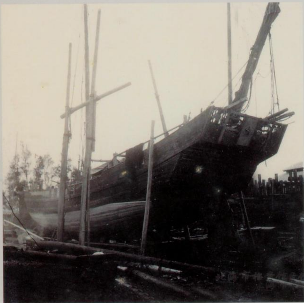
渔船修造现场 市档案馆 供
