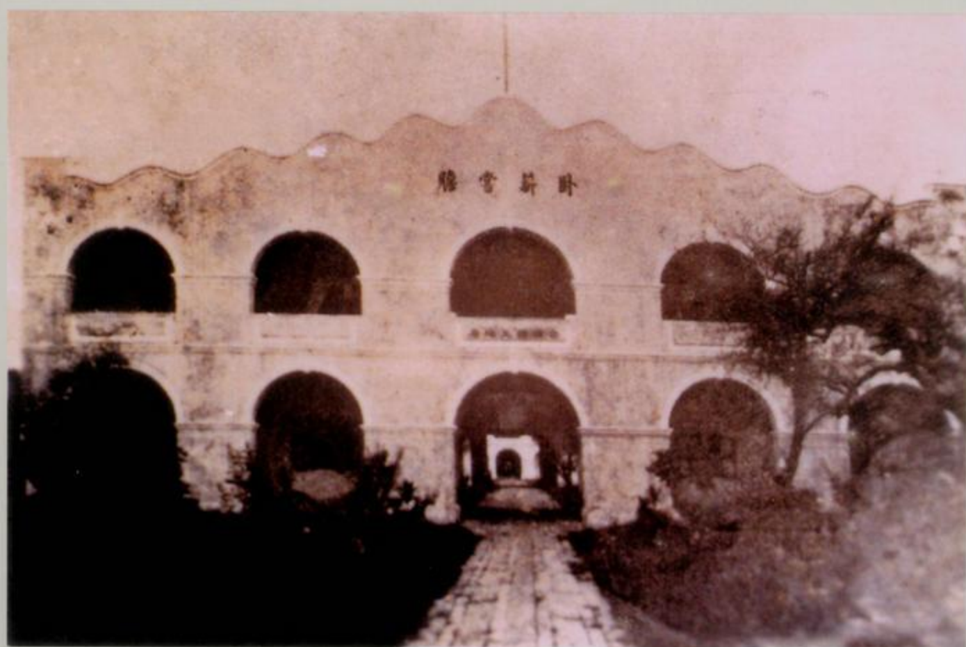
20世纪20年代合浦县土地局办公楼
