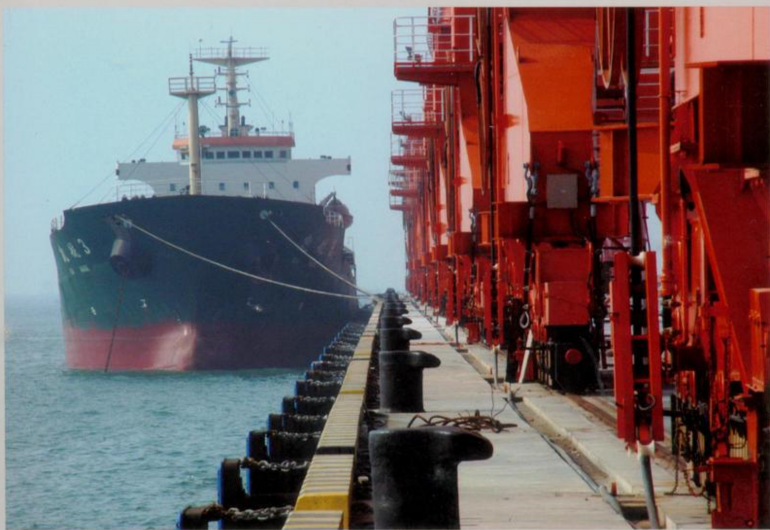
北部湾港北海铁山港码头
