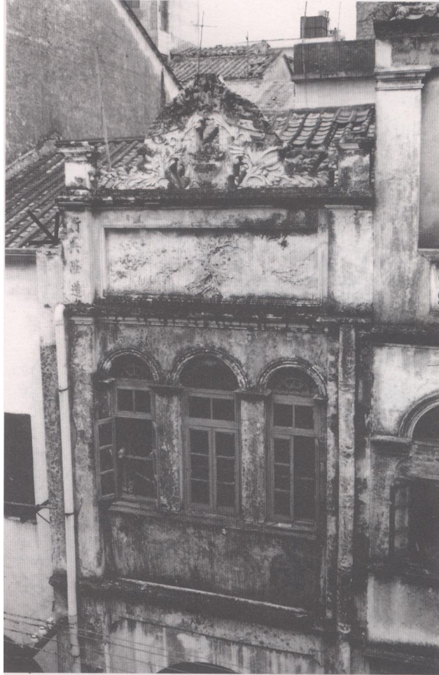
衡兴隆承建的珠海中路上水铺的一间骑楼商铺，临街花墙头左边墙柱上，“衡兴隆造”四字还清晰可见
