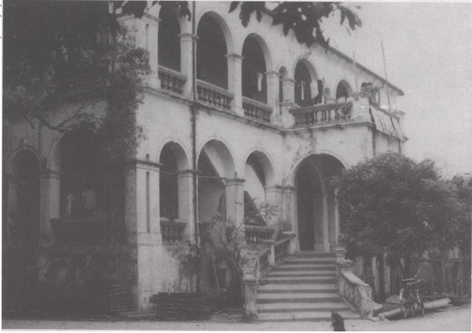
德领馆旧址门厅前的弧形阶梯
